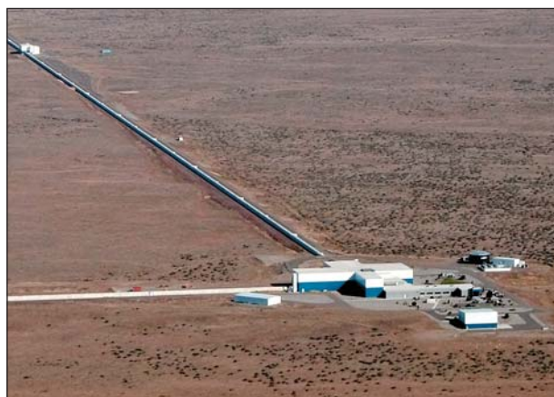
Рис.4. Вид с высоты птичьего полета на американские детекторы гравитационных волн — интерферометры с четырехкилометровыми плечами LIGO (слева — в Хэнфорде, справа — в Ливингстоне).
